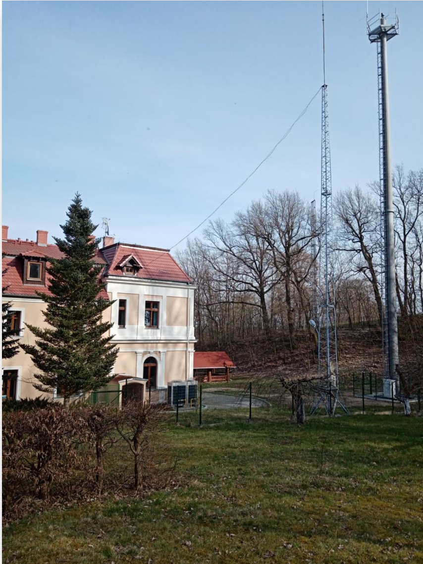
Kamera telewizyjnej przemysłowej - maszt strunobetonowy o wysokości 32 m
